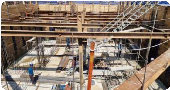
11월 완공될 대천지점 신축공사 현장
