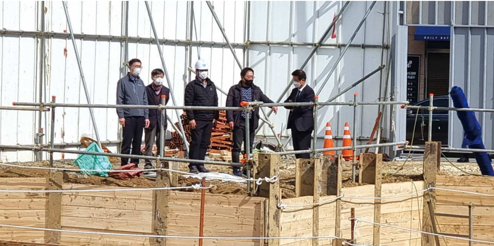
대천지점 신축공사 현장을 찾은 이상용 조합장
